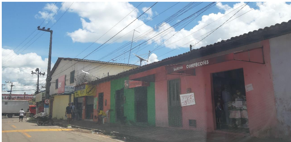
Loja SKY Localizada na Rua do Sol, Centro
